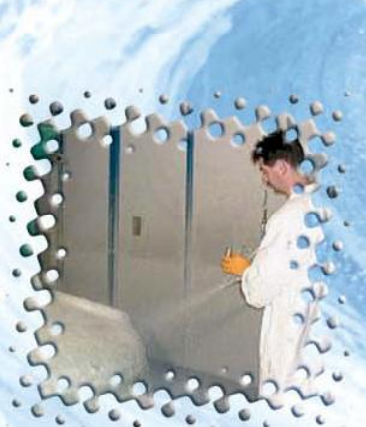
GFK-Spritzvorgang für Behälterboden
